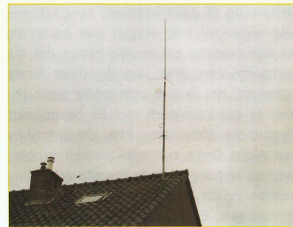
Een enkele antenne, helemaal vrijstaand. Hier met een draadantenne eronder. Een tamelijk ideale situatie.
